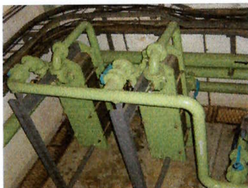
Figura 8.4: Circuitos de água pura, bruta, trocador de calor
