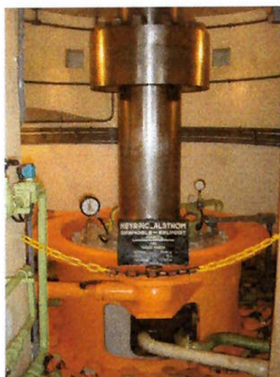
Figura 8.5: Eixo, acoplamento, sistema de regulação
