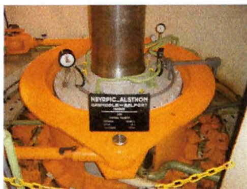
Figura 8.7: Atuador e anel de regulação
